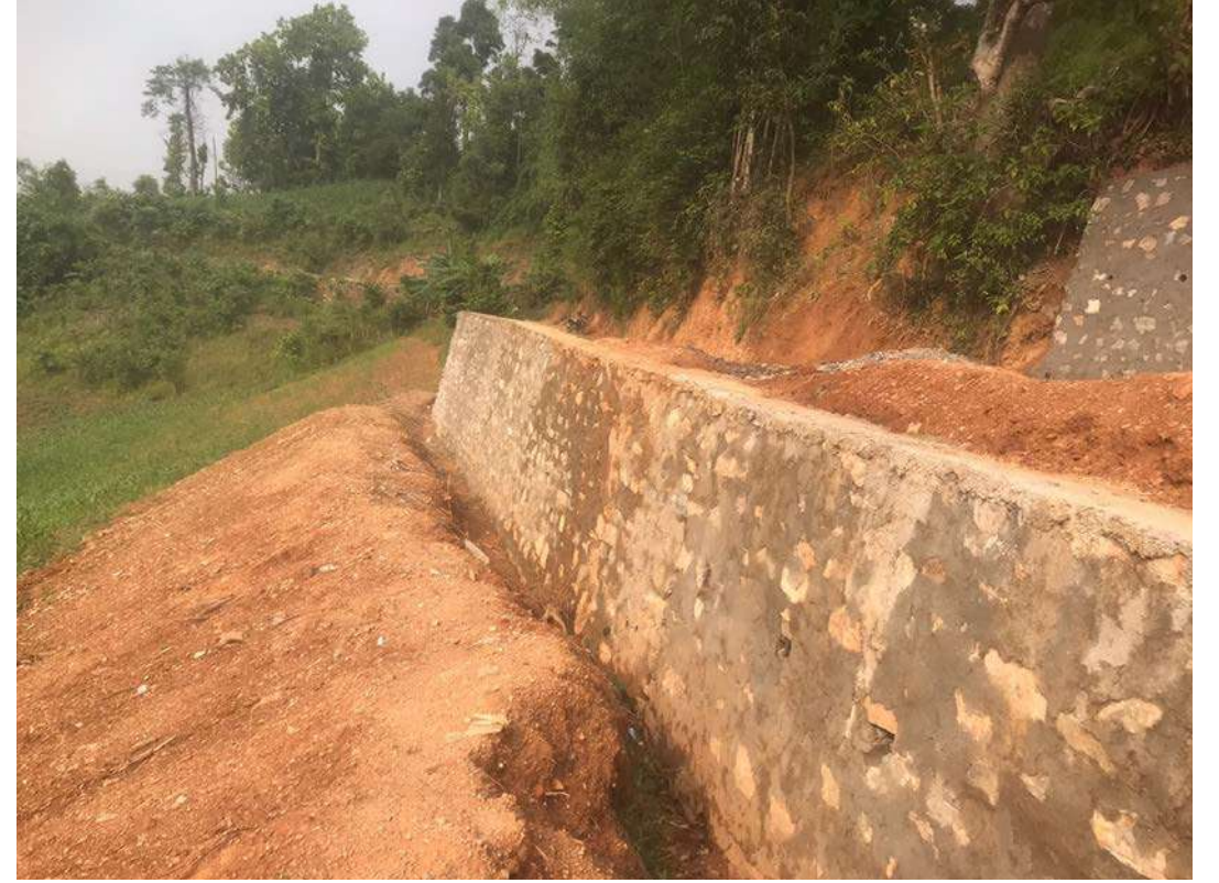
तोस मोटरबाटो ग्याबिन निर्माण वडा नं.५
