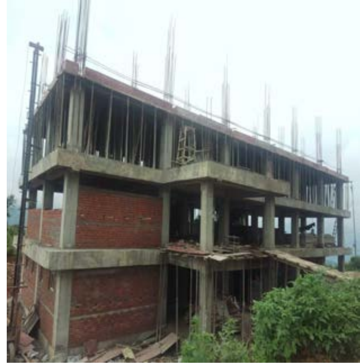
रुन्खा दह मा.वि. १६ कोठे भवन निर्माण (हालको अवस्था)
