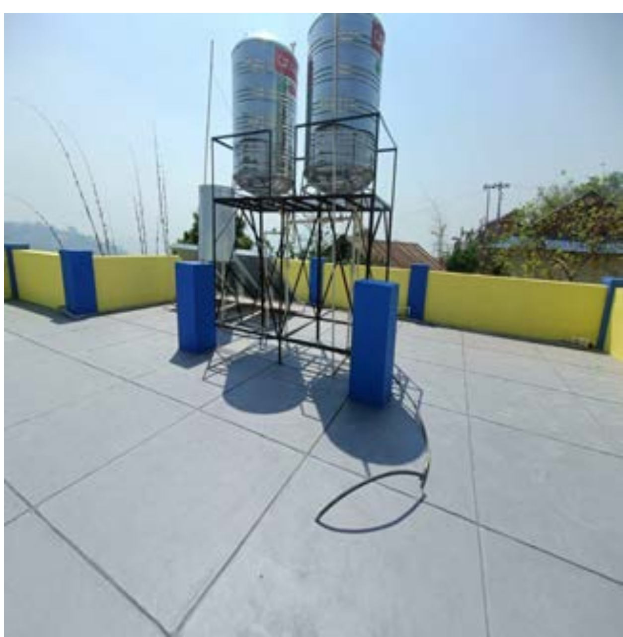
स्वास्थ्य चौकी भवन निर्माण गुल्मीदरबार-०६, गुल्मी
