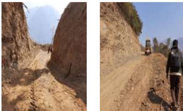
सिमलपाटा ठूलाखर्क चारखुट्टे सडक नयाँ ट्रयाक निर्माण
